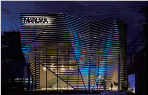
北側ファサードライトアップ全景（コーポレートカラー）
