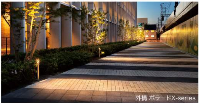
外構 特注樹木用アップパー・ダウンライト (サークルライト) 光源：LED 7W×8 灯 ポール灯 LOUIS POULSEN LP NEST 光源：CDM-T 70W×1 灯
