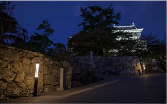
照明器具 フロアウォッシャー照明 LED 3000K 4.5Wx1 照明器具 壁面ライン照明 LED 3000K 9.9Wx1 / L:722
