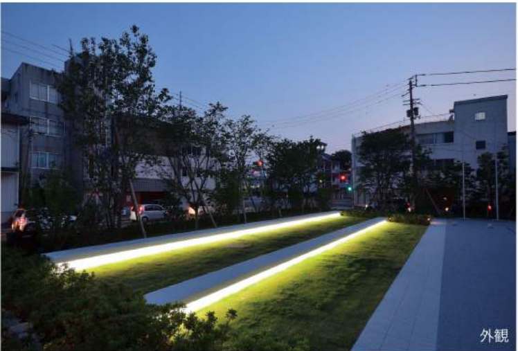
外観 地中埋設インジケータライト J-597改 光源:LED4.2W 外構 特注ベンチ照明 光源:LED6W/m
