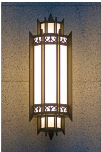
外構 間接照明 カラーキネティクスewグレース+ewフレックス 特注復刻ブラケット 光源：LED14W
