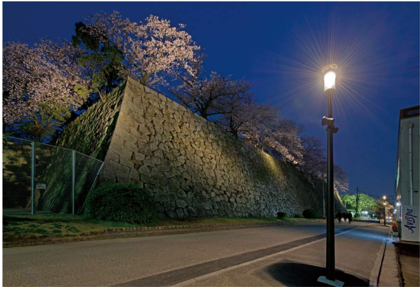
外構 特注ポール灯 BEGA H4555B+T4047B 光源：LED 40W×1 灯 +LED 26W×1 灯
