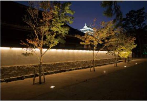
照明器具 フロアウォッシャー照明 LED 3000K 4.5Wx1 照明器具 壁面ライン照明 LED 3000K 9.9Wx1 / L:722
