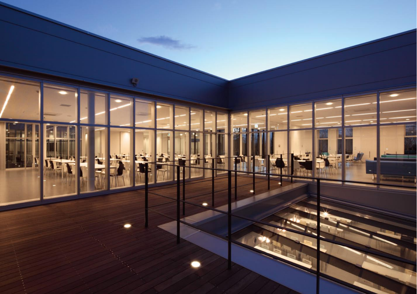
2 階デッキテラス
