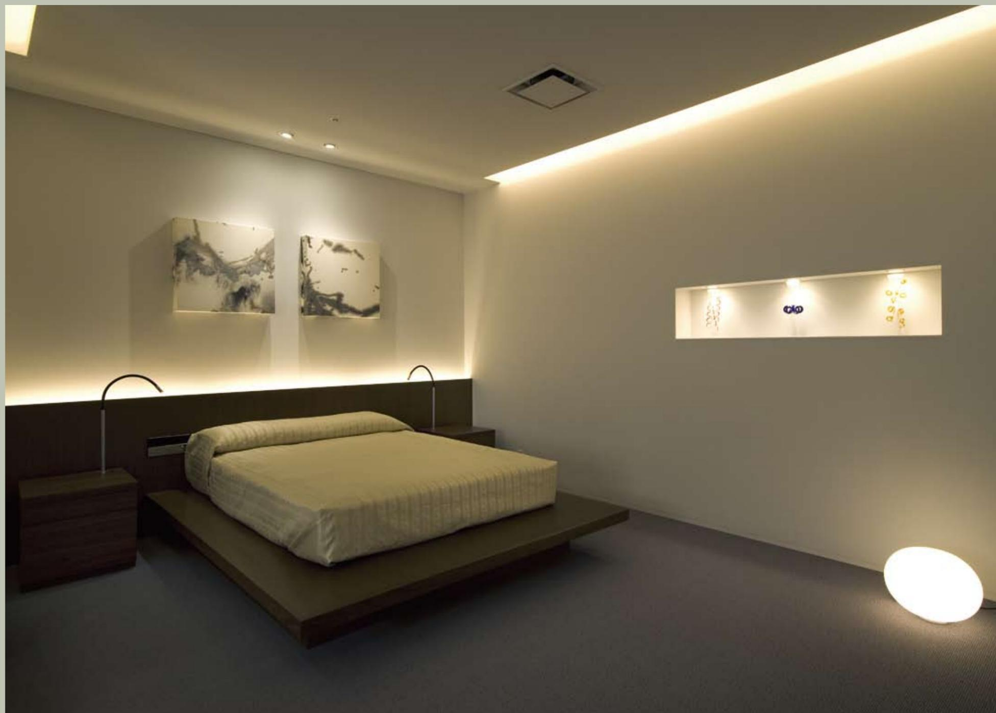
寝室の照明はまぶしさを避け、優しい光により快適な睡眠環境を創り上げることが大切です。天井面やベッドヘッドの裏側に仕込まれた間接照明の拡散光によってベース照明をとり、手元で調光の可能な照明を設置（写真ではファイバー照明）、さらに就寝以降のためのフットライトが必要です。人の感覚は照明の位置高さにより落ちつき感が変わります。光の重心の変化による雰囲気の変化をします。色温度の低い光のたまりが低い位置にあるとゆったりと落ち着いた感覚変化を体感出来ます。
