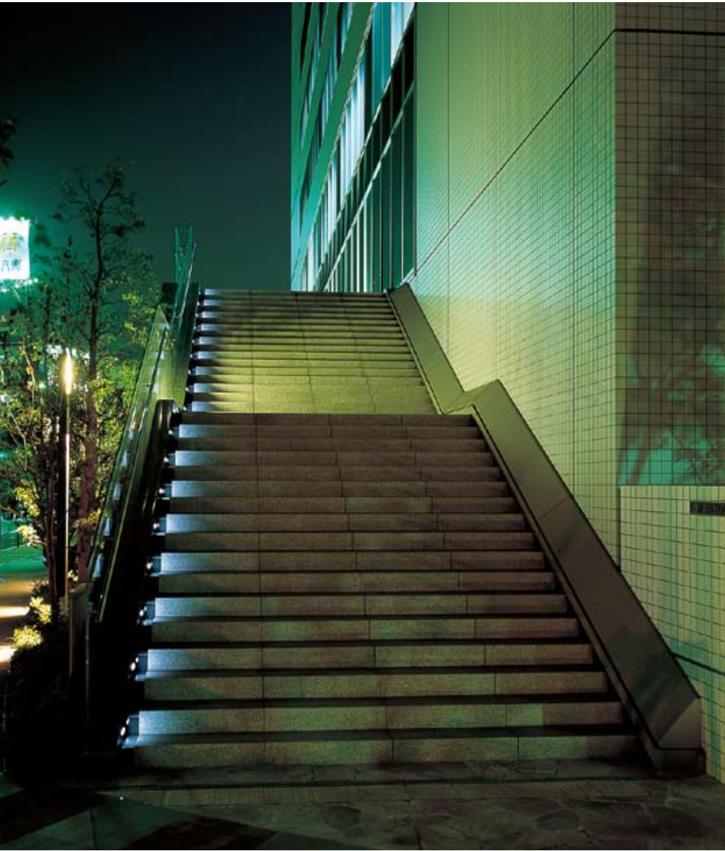
大崎フロントタワー 所在地:東京都品川区大崎一丁目二番 設 計:株式会社三菱地所設計 竣 工:2005年7月
