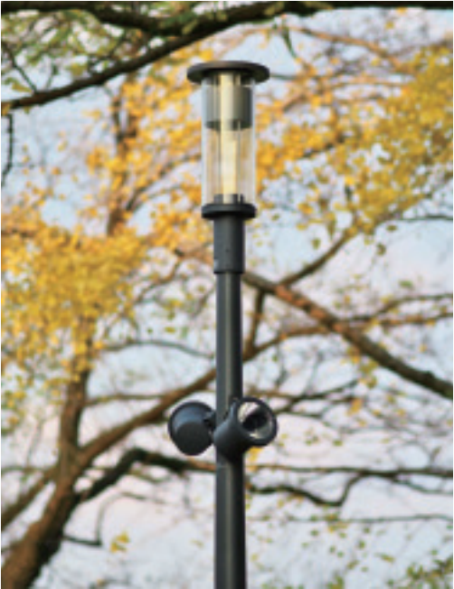
外構 特注ポール灯 BEGA H4555B+T4047B 光源：LED 40W×1灯+LED 26W×1灯
