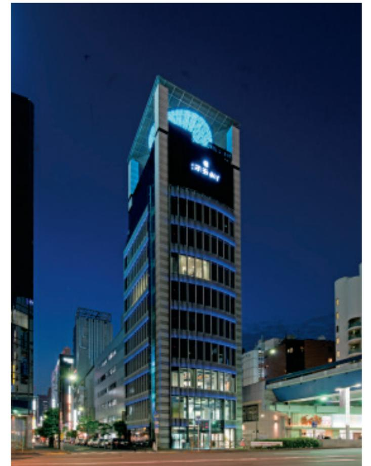
H&M心齋橋店は、H&Mの国内最大規模の店舗としてオープンしました。凹凸のあるストライプ状のガラスFacadeは、凸部内部にRGBのLEDを全面に配置し、特殊な拡散幕をガラス内部に施工することで均一な面発光を実現しています。12本の発光するストライプは、通常は白色に点灯し、設定した時間やイベント時には、それらに合わせたシーンプログラムにより、様々な光色に変化します。
